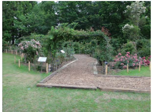
図8 ウッドチップ舗装.
