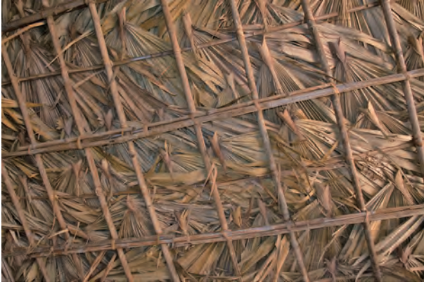
図7 内側から見たオウギヤシ加工場の屋根. 竹製の骨組みの間からオウギヤシの葉身が見える。
